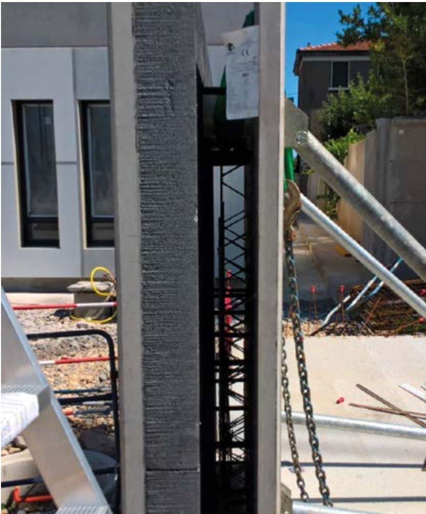
Les panneaux Knauf NEXTherm® Mur-B2i optimisent ainsi l'épaisseur des voiles béton avec l'un des meilleurs lambda du marché. KNAUF
