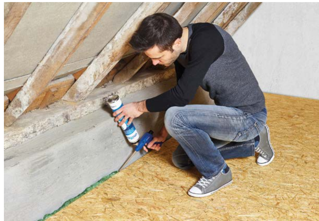
Plaque isolante en mousse de polyuréthane rigide (PIR) revêtue d'un complexe multicouche étanche au gaz et associée sur un côté à un panneau OSB de 12 mm. UNILIN
