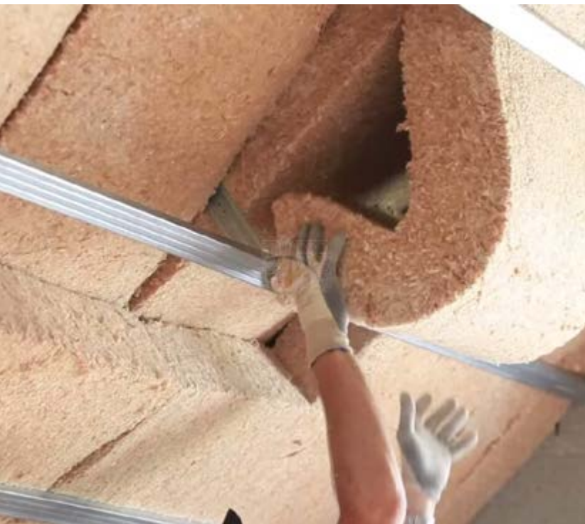
Biofib' chanvre, c'est l'isolant écologique par excellence. Composé de fibres naturelles de chanvre, résistantes et imputrescibles, ce produit offre une très bonne rigidité et une excellente tenue mécanique dans le temps. BIOFIB
