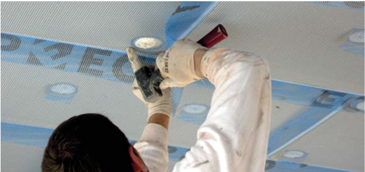
Le panneau Ecap Nano est conçu avec un isolant nano technologique en aérogel, couplé à une membrane transpirante et à une armature en fibre de verre, le tout agréé. EDILTECO
