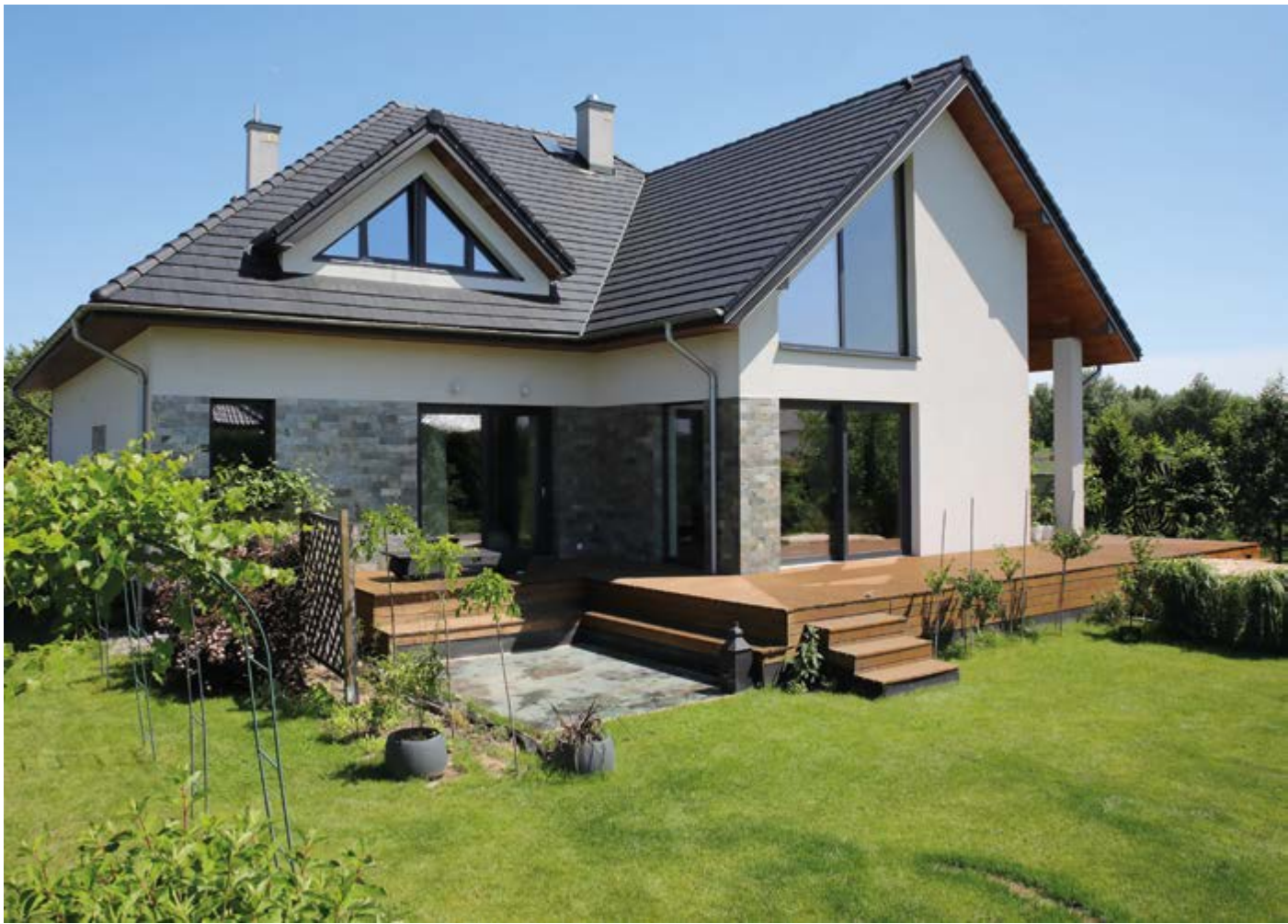
Toiture ardoise chez BMI GROUP
