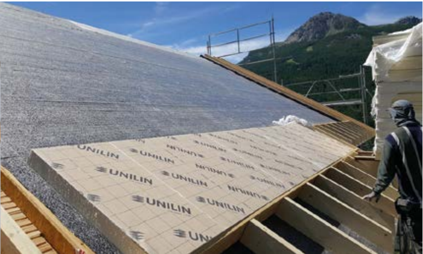
Le système Sarking est un procédé d’isolation thermique de toitures inclinées caractérisé par la pose de panneaux isolants rigides au-dessus des chevrons ou des voliges. TERREAL
